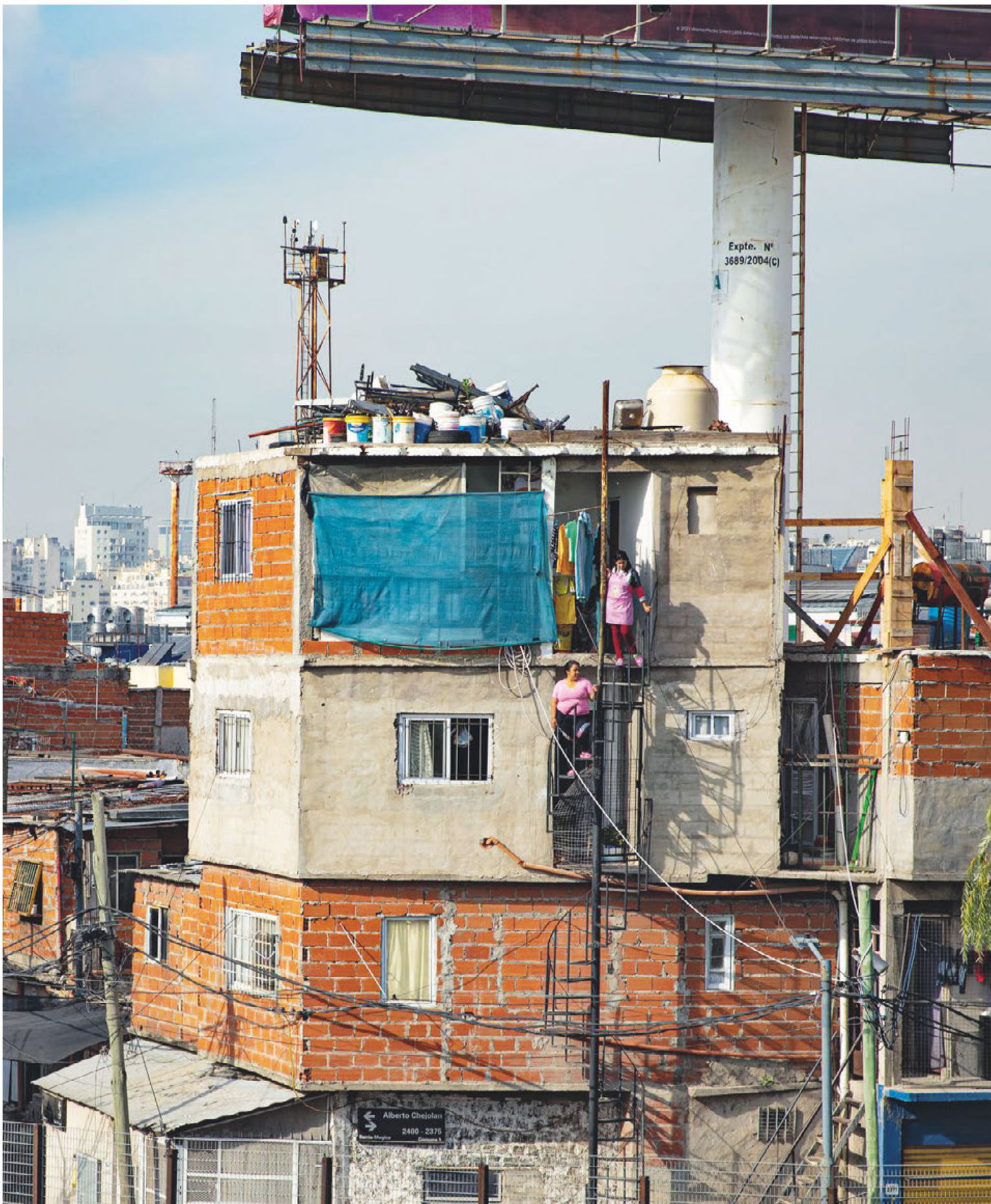
BUENOS AIRES — Die ungeordnete und unkontrollierte Bebauung in den weitläufigen «Villas Miseria», den Elendssiedlungen von Buenos Aires, ist für viele Familien, die nahe dem Stadtzentrum wohnen möchten, die einzige erschwingliche Option.
